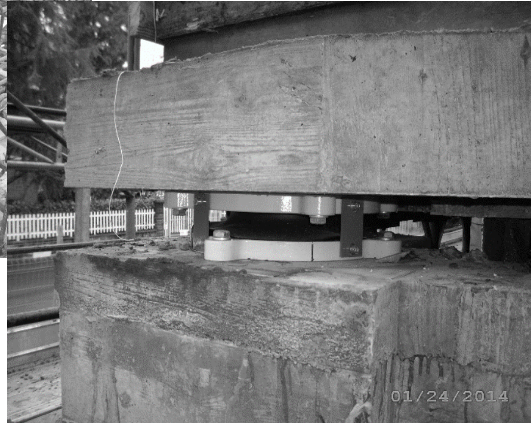
Isolatore posizionato tra muro di cantina e prima soletta
