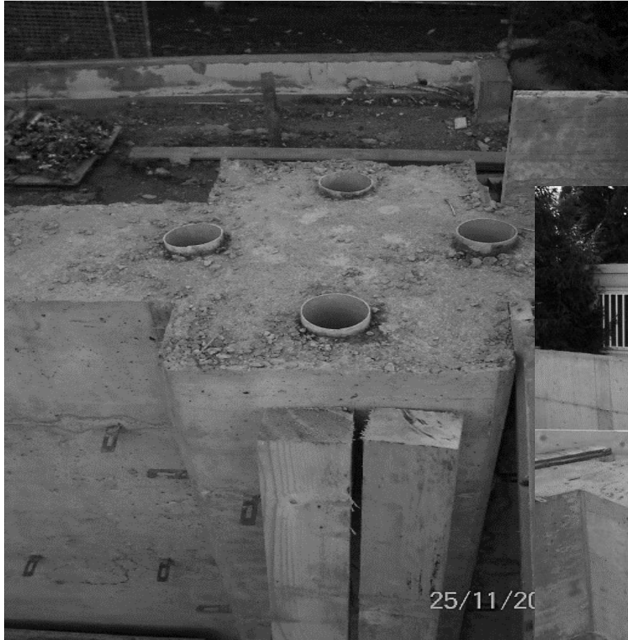
fori per l'ancoraggio degli isolatori
